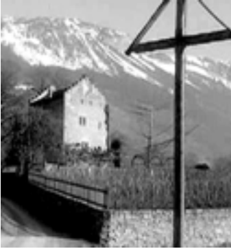
La maison du poète à Veyras
